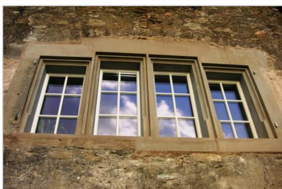
2007 wurden die Sandsteineinfassungen vom gotischen Gewände, von den nach Südwesten gerichteten Fenstern im obersten Stock, umfassend renoviert. Die ältesten Teile dieser Sandsteineinfassungen stammen aus dem Jahr 1520. Immer wieder ausgebessert und teilweise mit Eichenholz abgestützt, waren Teile der Einfassungen gebrochen und drohten sogar abzustürzen. Jetzt zielt ein fachlich einwandfreies Sandsteingewände die neuen Fenster.
